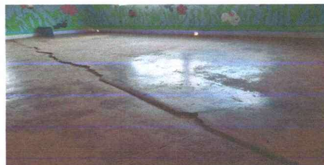
Foto 6: Sustitución de piso a cerámico por deterioro.
