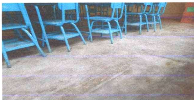
Foto 5: Sustitución de piso a cerámico por deterioro.
