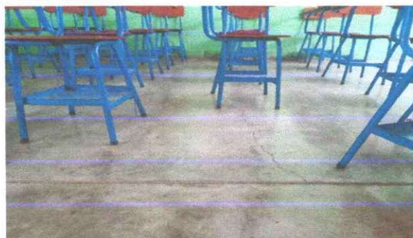
Foto 4: Sustitución de piso a cerámico por deterioro.
